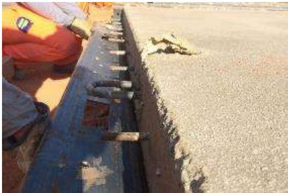
Figura 17 – Detalhe da desenforma da porção superior do painel (pinos de cisalhamento).
