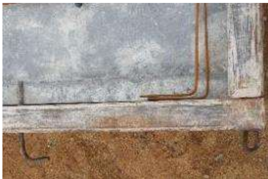
Figura 20 – Fôrmas metálicas acomodadas com auxílio de pinos metálicos.
