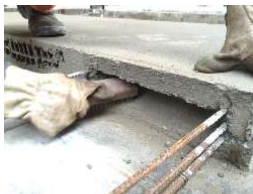
Figura 18 – Vasculhamento com escova de aço dos nichos.
