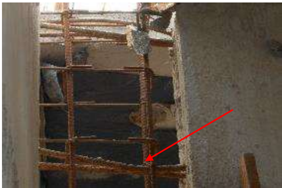
Figura 24 – Ligação das esperas da viga junto à armadura do pilar.
