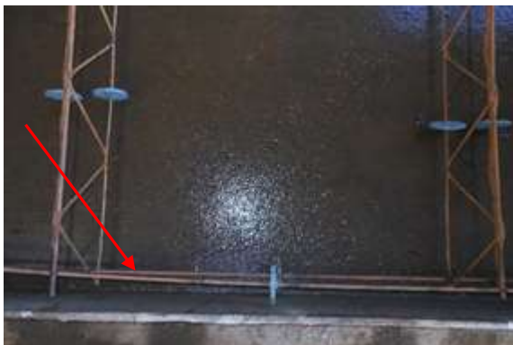
Figura 08 – Posicionamento das barras de aço de reforço na porção inferior do painel.
