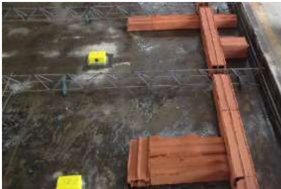
Figura 10 – Posicionamento dos blocos cerâmicos destinados à passagem de tubulações hidráulicas.
