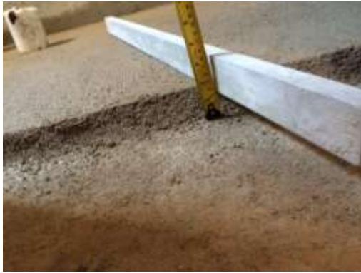
Figura 30 – Lançamento do contrapiso.
