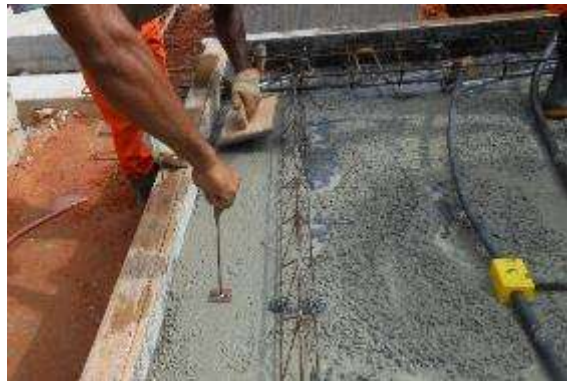
Figura 14 – Conferência da espessura da primeira camada de concreto com o auxílio de galga.
