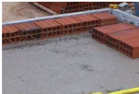
Figura 16 – Posicionamento dos blocos cerâmicos com furos no sentido horizontal.
