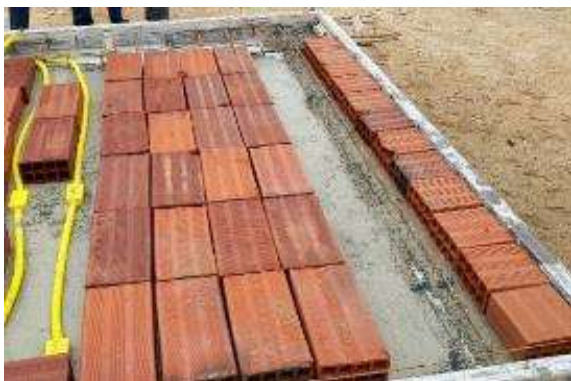
Figura 15 – Posicionamento dos blocos cerâmicos.
