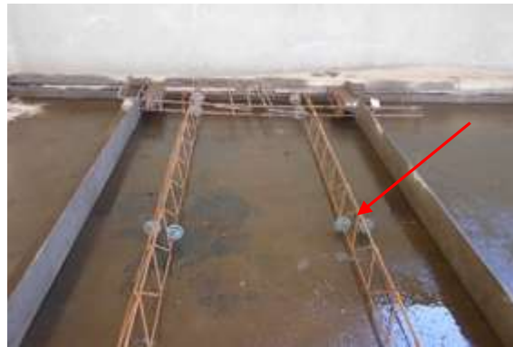
Figura 07 – Posicionamento dos espaçadores plásticos..
