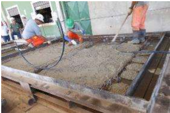
Figura 13 – Lançamento da primeira camada de concreto.
