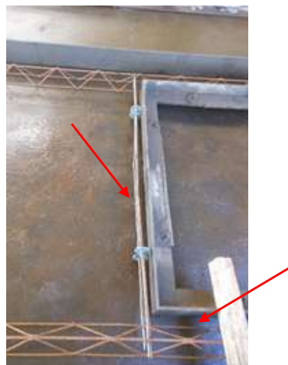
Figura 09 – Posicionamento das barras de aço de reforço na borda inferior do vão de janela e das treliças nas bordas laterais do vão de janela.
