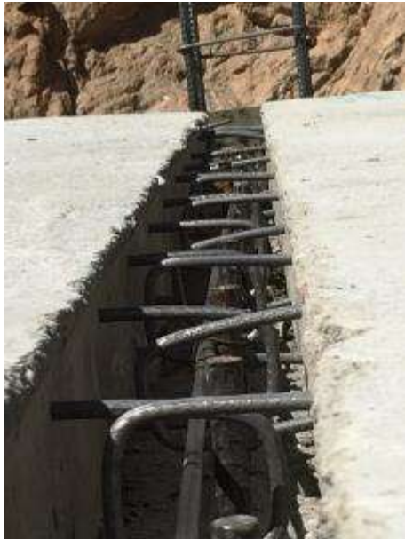
Figura 29 – Detalhes das ligações entre lajes.
