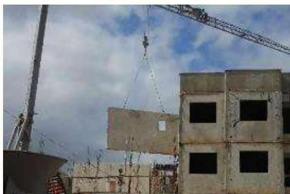
Figura 22 – Içamento do painel por meio de grua.
