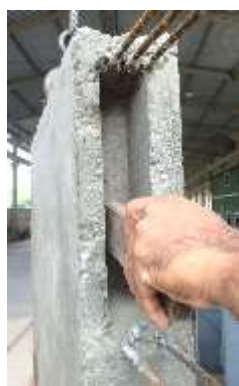
Figura 18 – Vasculhamento com escova de aço dos nichos.
