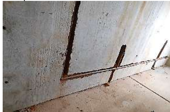
Figura 31 – Instalação das tubulações de hidráulica.
