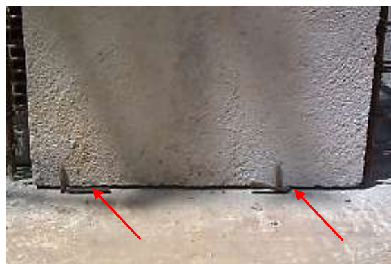
Figura 23 – Painel apoiado sobre barras metálicas.
