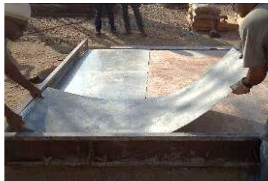
Figura 21 – Posicionamento das chapas de aço galvanizadas.
