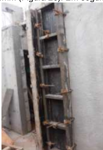
Figura 26 – Fixação da fôrma para concretagem do pilar.
