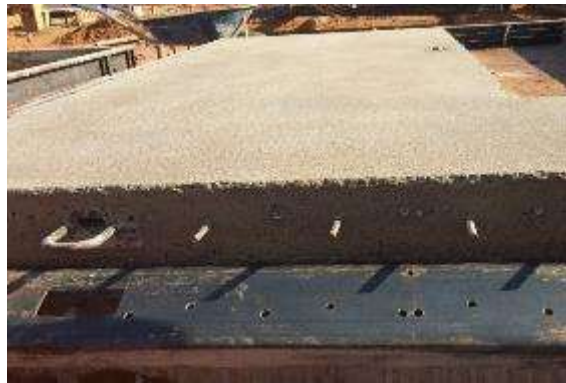
Figura 17 – Detalhe da desenforma da porção superior do painel (pinos de cisalhamento).
