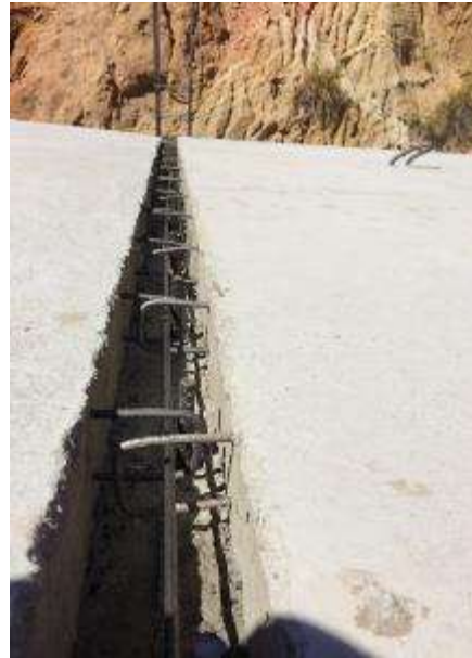
Figura 29 – Detalhes das ligações entre lajes.
