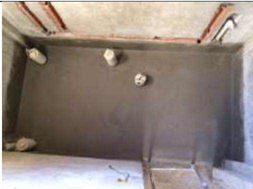
Figura 32 – Aplicação da argamassa polimérica (2ª demão).
