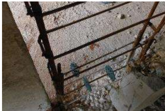
Figura 25 – Posicionamento dos espaçadores plásticos circulares.
