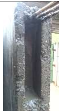
Figura 19 – Jateamento com água da área vasculhada (nichos).
