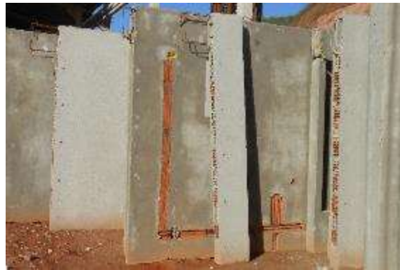
Figura 11 – Painel de hidráulica concretado.
