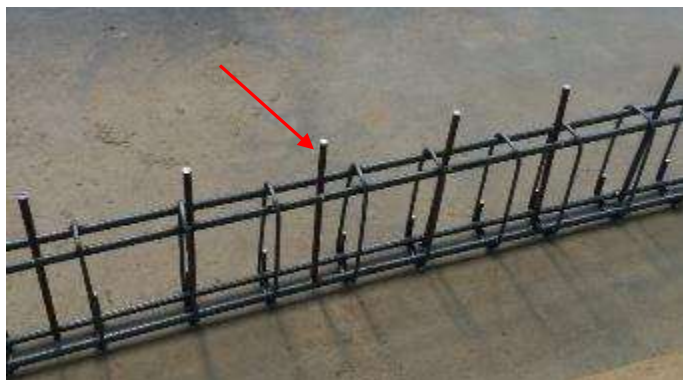
Figura 05 – Armação da viga com pinos de cisalhamento.
