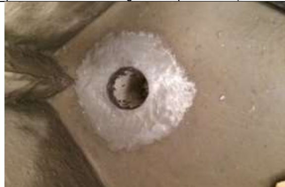
Figura 33 – Tratamento da interface da tubulação de esgoto e contrapiso com aplicação de tela poliéster e argamassa polimérica.
