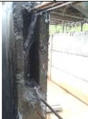
Figura 19 – Jateamento com água da área vasculhada (nichos).
