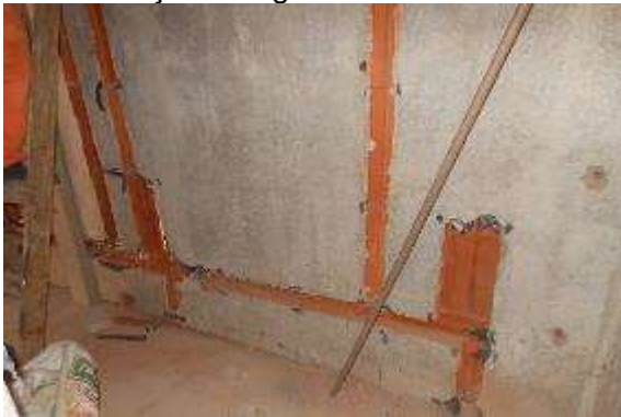
Figura 30 – Remoção dos blocos cerâmicos para a instalação das tubulações de hidráulica.
