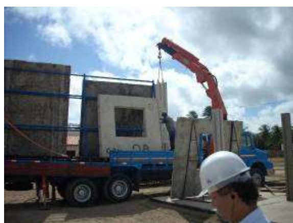
Figura 27– Içamento para transporte do painel.
