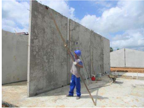
Figura 30 – Detalhe do escoramento do painel.
