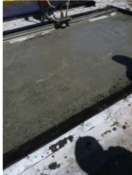
Figura 21 – Adensamento do concreto com régua vibratória.
