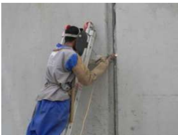
Figura 31 – Soldagem entre painéis.
