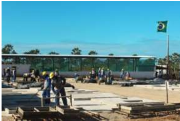
Figura 3 – Vista geral das pistas de fabricação dos painéis.
