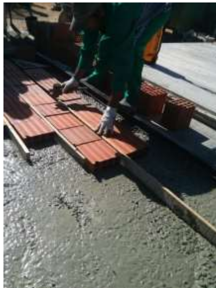
Figura 22– Distribuição dos blocos cerâmicos.
