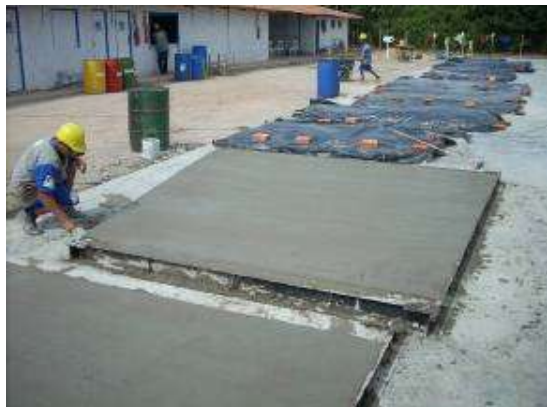
Figura 25– Proteção dos painéis com lona plástica.
