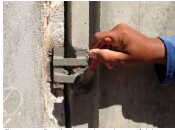
Figura 32 – Detalhe de produto primer epóxi rico em zinco.
