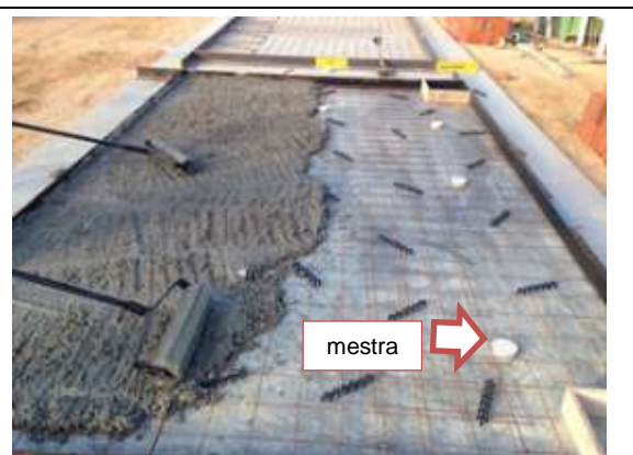
Figura 19 – Detalhes do posicionamento da tela eletrossoldada sobre espaçadores plásticos e das mestras.
