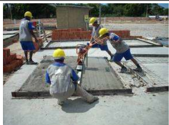
Figura 24 – Vibração da argamassa.
