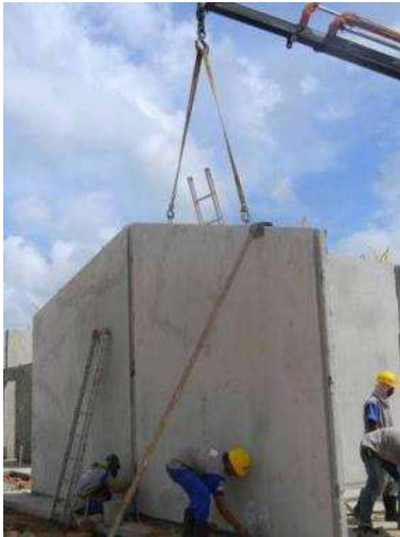
Figura 29 – Detalhe do assentamento da parede.
