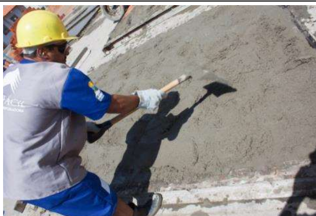
Figura 23 – Distribuição da argamassa.
