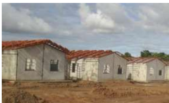
Figura 37 – Unidades habitacionais em fase de montagem.
