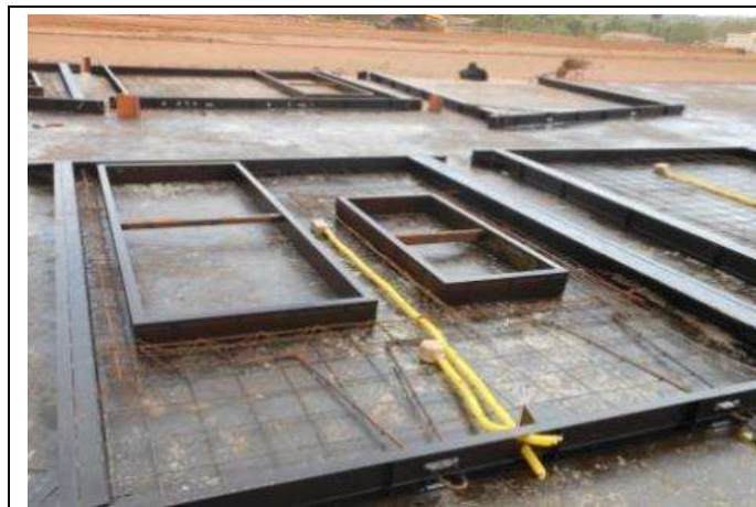
Figura 5: Detalhes das fôrmas metálicas nos painéis durante procedimento de moldagem.
