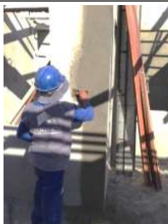
Figura 36 – Finalização das juntas.
