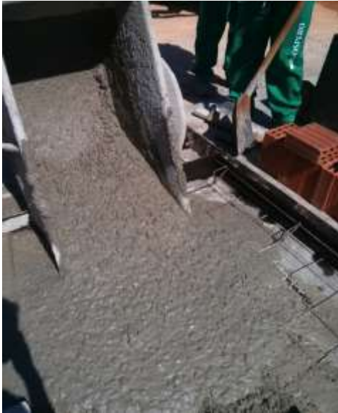
Figura 20– Lançamento do concreto.
