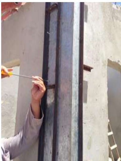
Figura 33 – Preparação da forma metálica para grauteamento.
