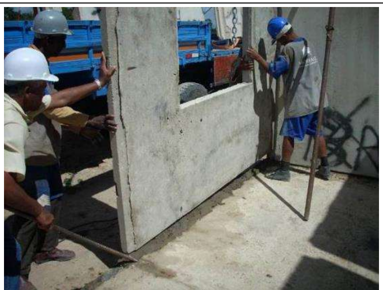
Figura 16 – Alinhamento do painel.
