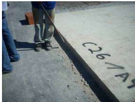
Figura 26– Identificação e desenforma dos painéis.
