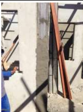
Figura 35 – Aplicação de tela de poliéster e argamassa nas juntas.
