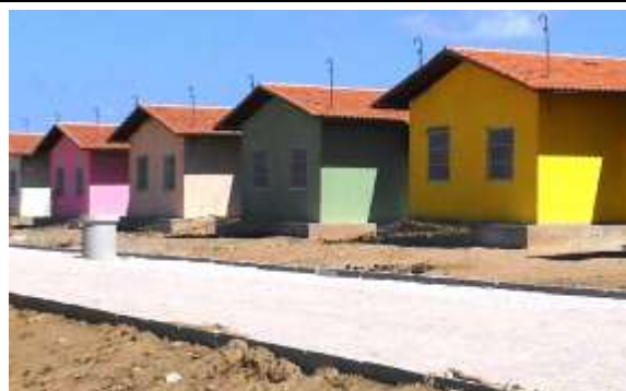
Figura 38 – Unidades habitacionais acabadas.
