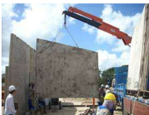
Figura 28– Montagem do painel no local definitivo.
