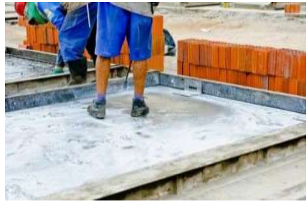
Figura 4 – Aplicação do desmoldante.
