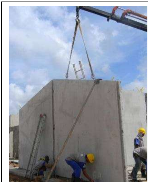
Figura 15 – Posicionamento do painel sobre argamassa.
