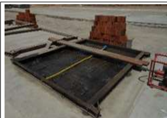
Figura 18 – Detalhe do painel sobre pista de concretagem.
