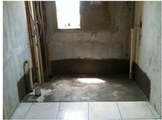
Figura 35 – Impermeabilização laje de concreto e barrado de 300mm na parede
