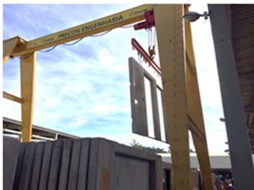
Figura 17 - Movimentação dos painéis para transporte
