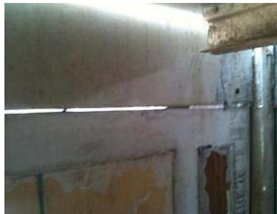
Figura 34 – Vista do vão entre a viga e o painel após a montagem
