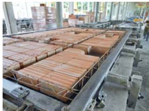
Figura 11 – Detalhe dos blocos cerâmicos entre as armaduras
