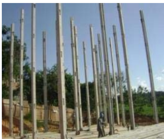
Figura 19 - Montagem dos pilares na fundação
