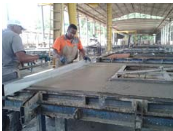
Figura 14 - Regularização com régua metálica
