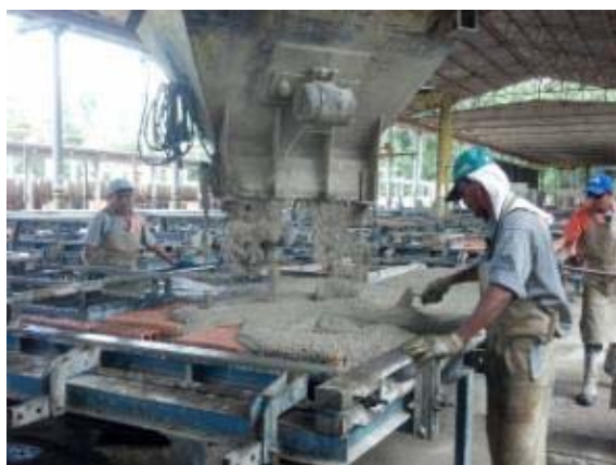
Figura 13 – Aplicação do concreto auto-adensável
