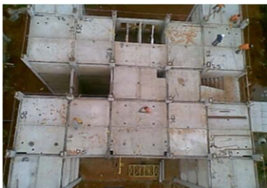
Figura 21 – Montagem das pré-lajes sobre escoramento metálico
