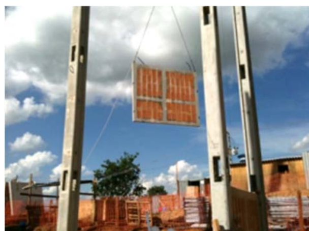
Figura 20 - Montagem dos painéis
