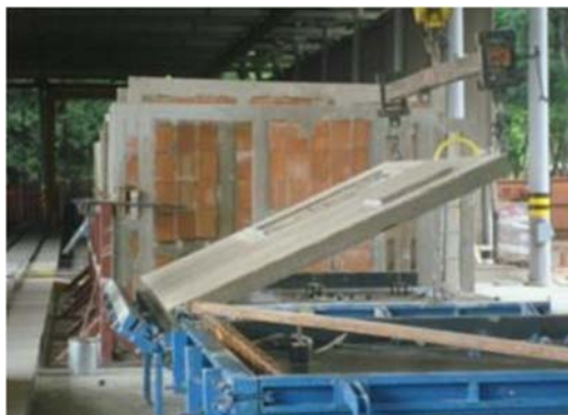
Figura 15 - Desenforma dos painéis
