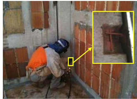
Figura 30 – Vista da ligação do painel, com solda elétrica
