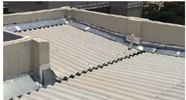
Figura 36 – Impermeabilização na interface dos rufos do telhado
