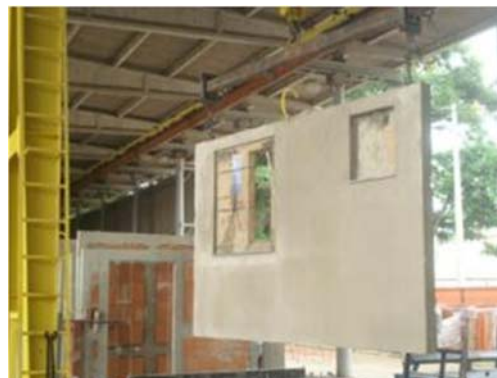
Figura 16 - Estocagem dos painéis para inspeção
