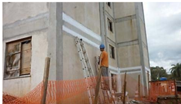
Figura 24 - Membrana acrílica sobre a tela de poliéster
