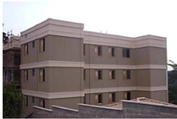
Figura 26 – Aplicação de pintura acrílica texturizada na fachada
