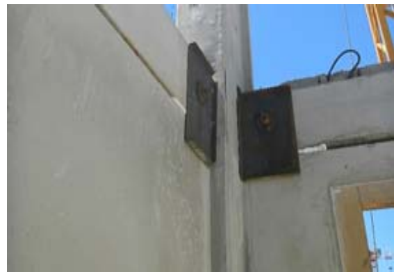
Figura 32 – Solidarização das vigas ao pilar
