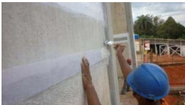
Figura 23 – Aplicação da tela de poliéster
