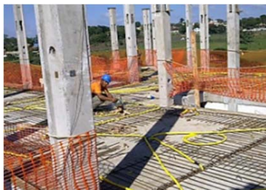
Figura 22 – Distribuição da armadura negativa e eletrodutos
