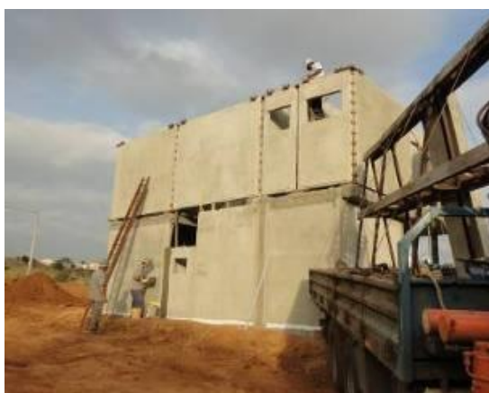
Figura 34– Sobrado em execução com emprego dos painéis pré-moldados mistos CASA EXPRESS
