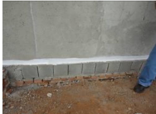
Figura 26– Aplicação de emulsão acrílica sobre a argamassa de regularização da base dos painéis.
