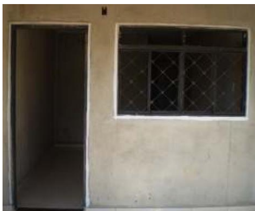
Figura 33– Aplicação de emulsão acrílica nos perímetros das esquadrias
