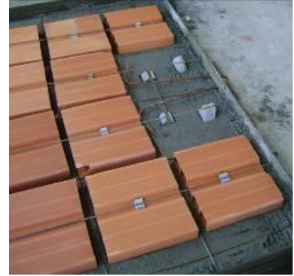
Figura 14– Posicionamento dos fios de aço para formação das malhas inferiores e superiores da armadura, conforme projeto de cada painel; detalhe dos espaçadores de argamassa.
