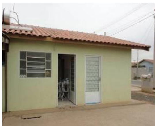
Figura 35– Casa térrea executada com emprego dos painéis pré-moldados mistos CASA EXPRESS
