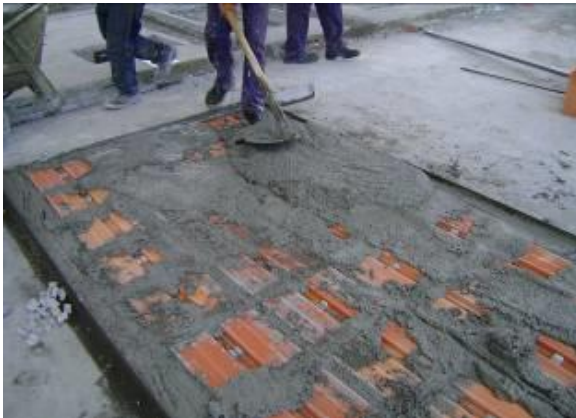
Figura 15– Lançamento da segunda camada de concreto, com preenchimento prévio das nervuras.
