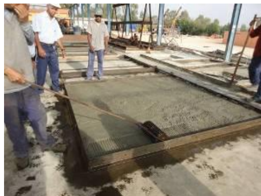
Figura 11 – Adensamento com rolo da primeira camada de concreto já lançada
