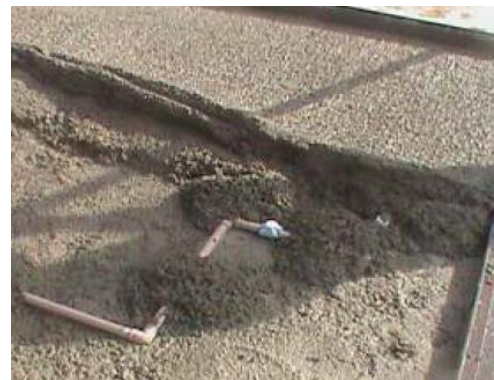
Figura 18– Lançamento de mais uma camada de concreto sobre as tubulações ( f_{ck} = 12\text{MPa} )
