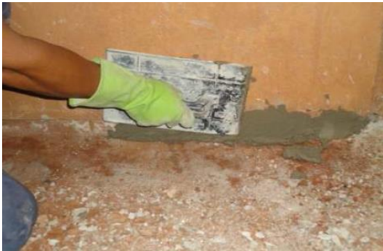
Figura 25– Aplicação de argamassa com aditivo impermeabilizante.
