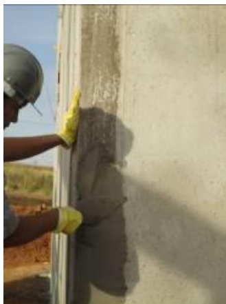
Figura 29– Acabamento das juntas com revestimento em argamassa
