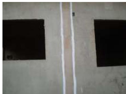
Figura 30– Aplicação da emulsão acrílica nas juntas entre painéis
