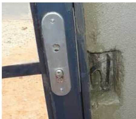
Figura 31– Embutimento da grapa no rebaixo do painel
