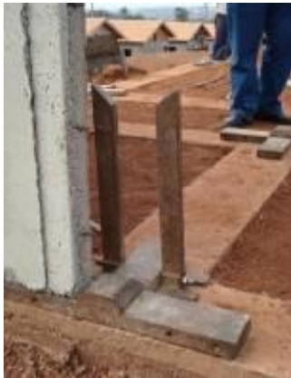
Figura 19– Base guia provisória para travamento inferior dos painéis
