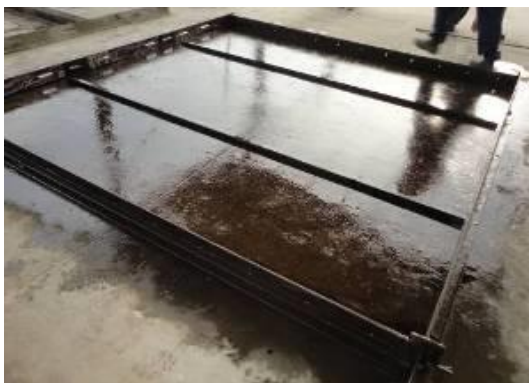
Figura10– Vista de uma fôrma para moldagem dos painéis, com desmoldante aplicado
