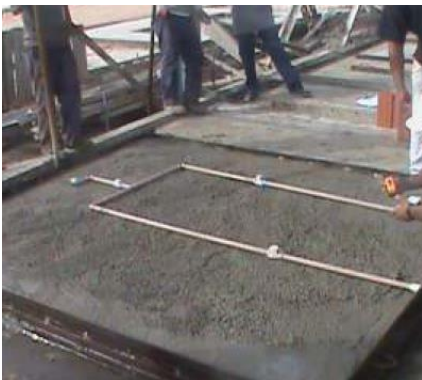
Figura 17– Posicionamento das tubulações hidráulicas sobre a segunda camada de concreto
