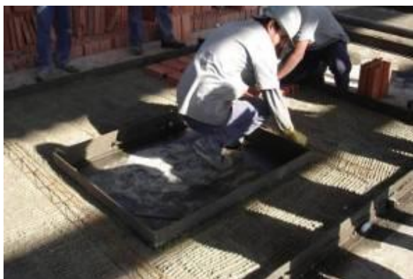
Figura 12- Posicionamento das treliças metálicas nas regiões dos vãos de janelas e portas
