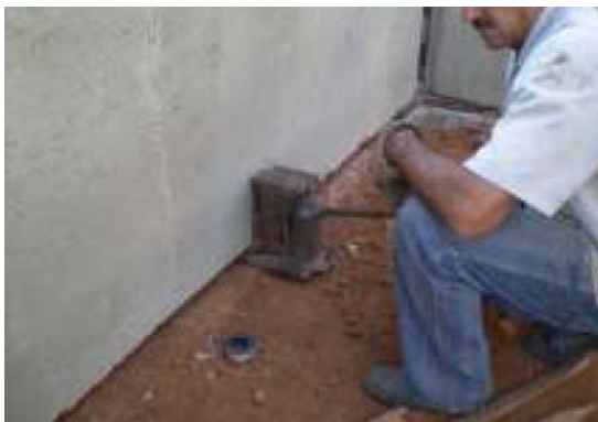
Figura 23– Ferramenta utilizada para aliviar a carga sobre as bases de ferro fundido, permitindo a sua retirada (movimentação de aproximadamente 2mm).
