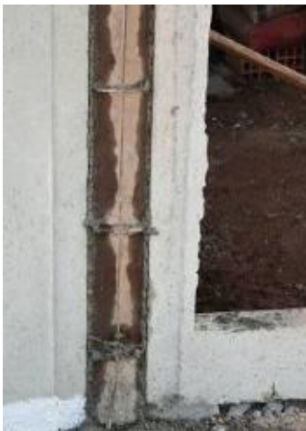
Figura 27– Grauteamento das juntas entre painéis.
