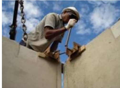
Figura 20– Peças provisórias para travamento superior dos painéis
