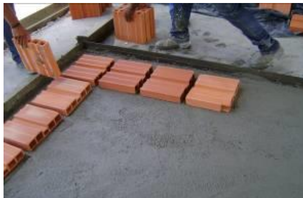
Figura13– Posicionamento dos blocos cerâmicos, conforme projeto de cada painel
