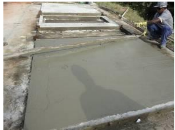
Figura 16– Execução da camada de argamassa de revestimento na face superior do painel
