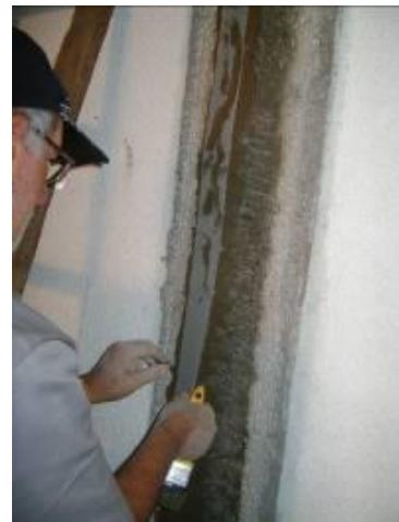
Figura 28– Colocação da tela de poliéster fixada com argamassa colante.
