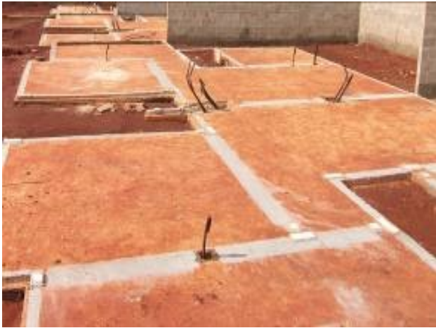
Figura 18 – Locação das paredes na fundação para apoio dos painéis
