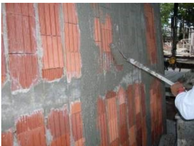
Figura 16 – Execução do chapisco rolado com o painel na vertical
