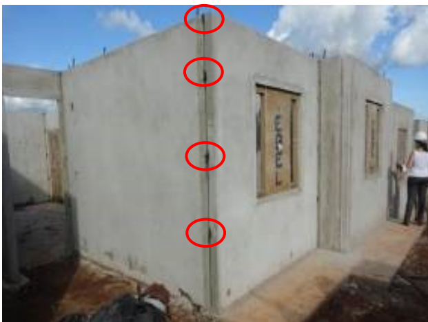
Figura 20 – Distribuição dos pontos de solda entre os painéis
