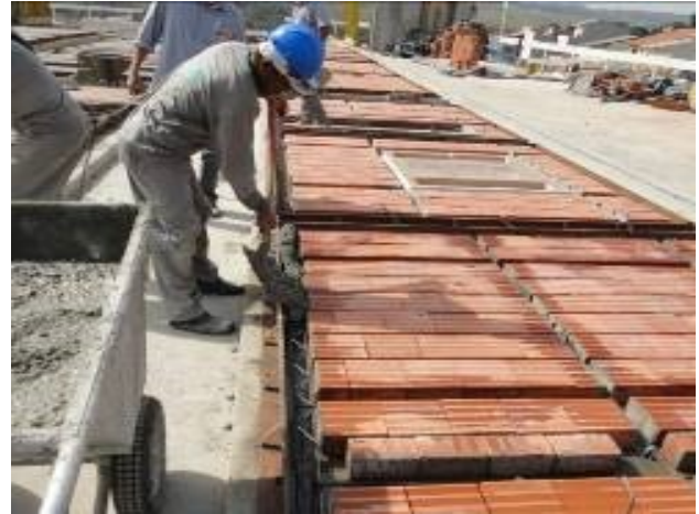
Figura 11 – Lançamento do concreto nas nervuras
