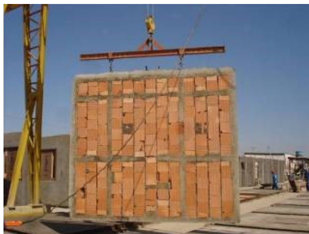
Figura 15 – Içamento do painel para aplicação do revestimento em argamassa na outra face do painel (na vertical)
