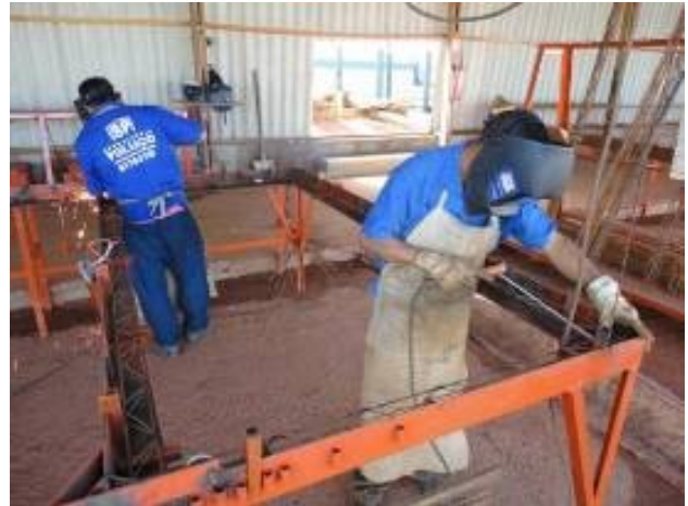
Figura 7 – Preparação das armaduras na central de armação, com emprego de gabarito
