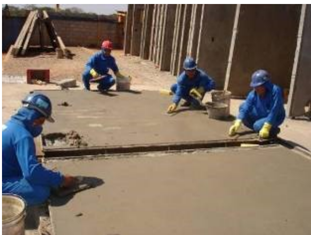
Figura 14 – Acabamento do revestimento em argamassa em uma das faces do painel (na horizontal)
