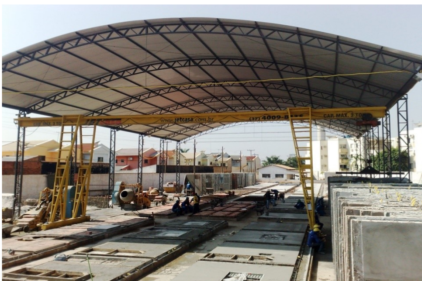
Figura 1 – Vista geral de uma unidade de produção de painéis em canteiro de obras
