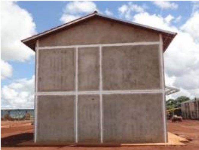
Figura 26 – Aplicação do fundo de junta para posterior preenchimento com selante acrílico
