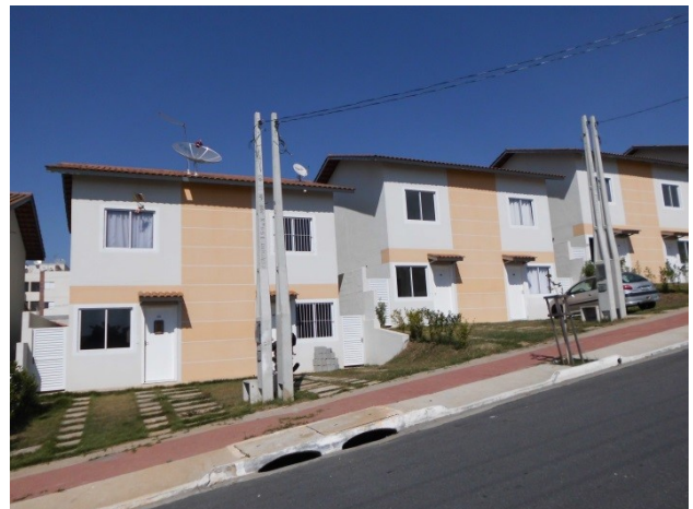
Figura 28 – Empreendimento de sobrados construídas com o sistema JET CASA
