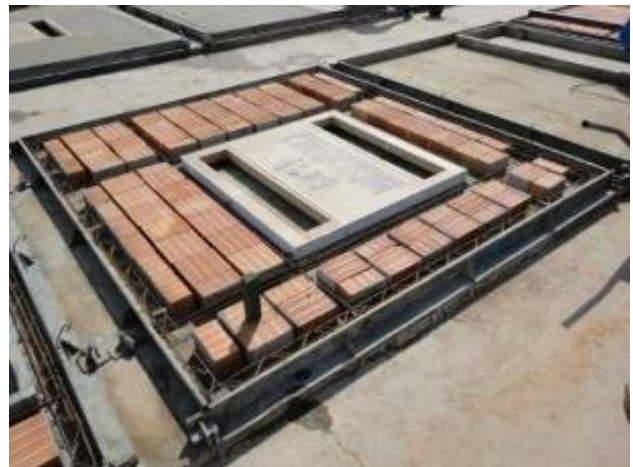
Figura 9 – Modulação dos blocos cerâmicos e posicionamento das esquadrias para concretagem
