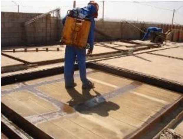
Figura 6 – Vista de uma fôrma sendo preparada para moldagem dos painéis
