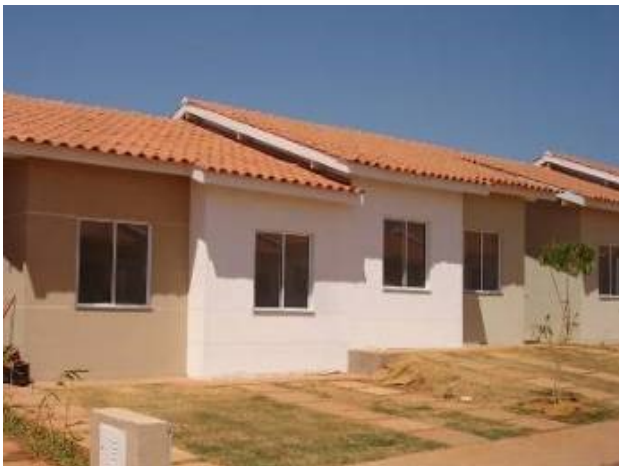
Figura 27 – Empreendimento de casas térreas construídas com o sistema JET CASA
