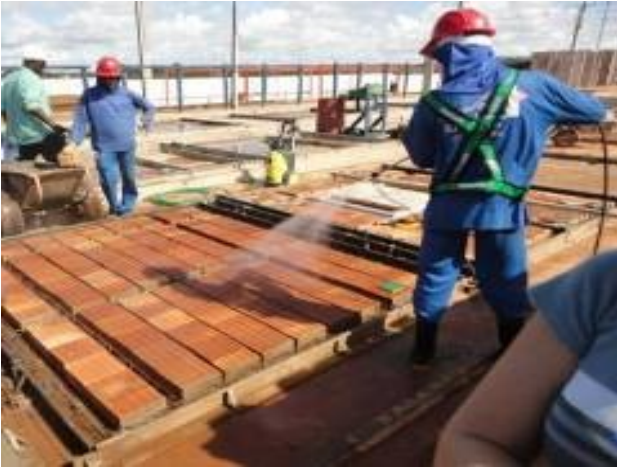
Figura 10 – Umedecimento do painel antes da concretagem das nervuras e do quadro externo
