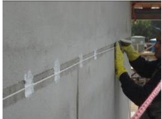
Figura 23 – Aplicação do fundo de junta para posterior preenchimento com selante acrílico
