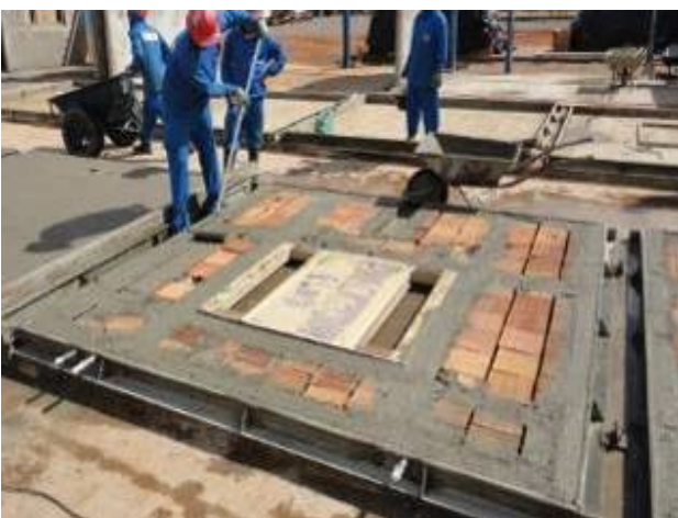
Figura 12 – Aplicação de chapisco com rolo de textura
