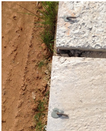
Figura 24 – Fixação da laje à parede com barra de aço e adesivo estrutural
