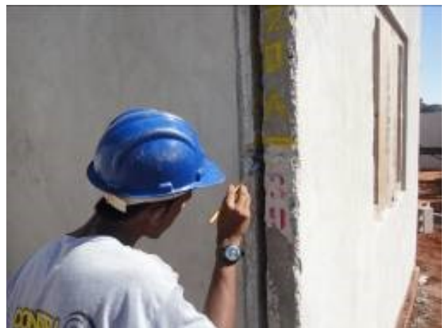
Figura 21 – Proteção anti-corrosiva aplicada na região das soldas entre painéis
