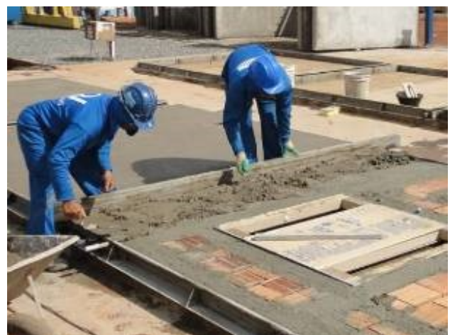
Figura 13 – Aplicação da argamassa de revestimento sobre o chapisco ainda úmido
