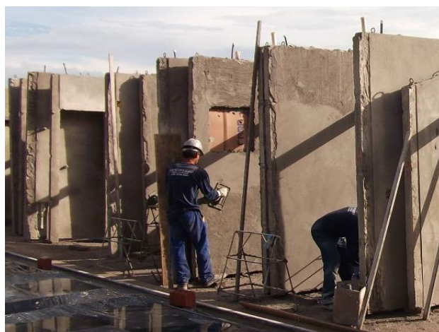
Figura 17 – Revestimento em argamassa aplicado com colher de pedreiro
