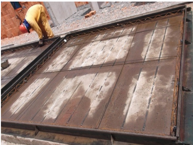
Figura 8 – Posicionamento das armaduras na fôrma
