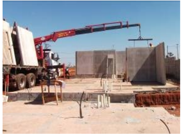
Figura 19 – Posicionamento dos painéis para montagem em obra
